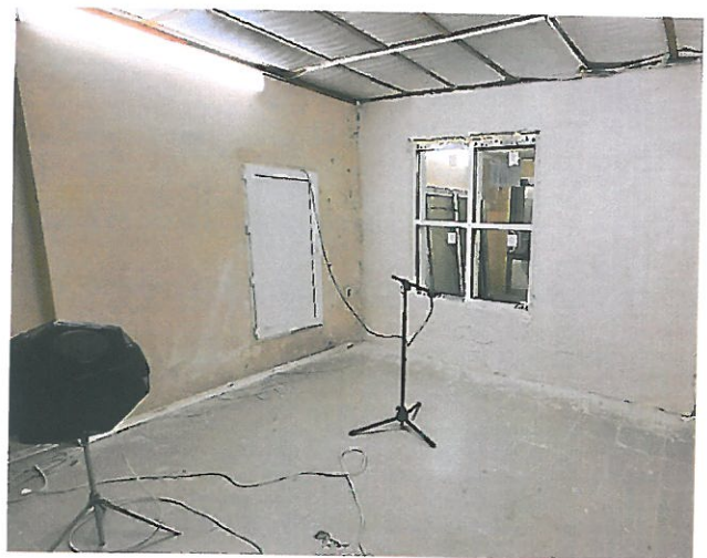
Фото 8. Камера высокого уровня, (испытание светопрозрачной конструкции рег. № 4825-22 в акустической камере)
