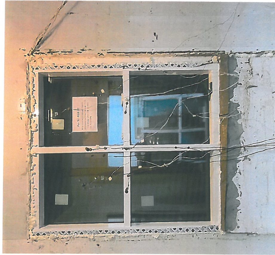
Фото 1. Светопрозрачная конструкция № 4831-22 в климатической камере (теплая сторона)
